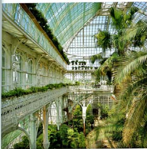
Während der Arbeiten am Palmenhaus in Schönbrunn. Am oben stehenden Bild sind deutlich die unterschiedlichen Verglasungen ersichtlich: die Alte, die ursprünglich Vorgesehene und die Neue.
