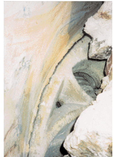
Pöggstall ehem. schloßkapelle Süd-Fenster unter Freilegung
