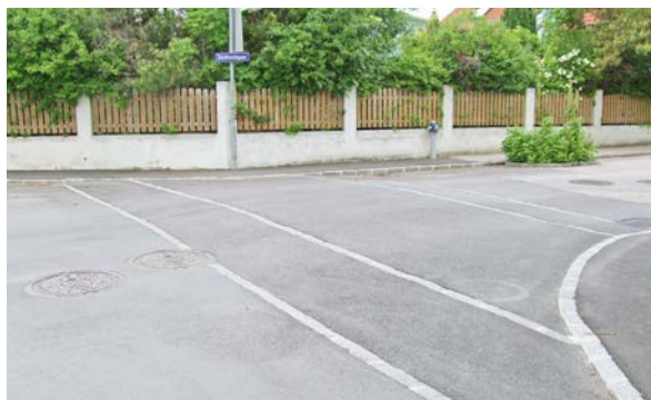
Abbildung 28: Beispiel für Gehsteigdurchziehung; Perchtoldsdorf, Rembrandtgasse
