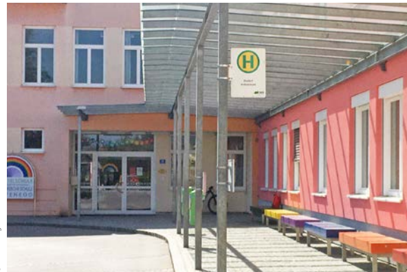
Abbildung 48: Haltestelle mit geschütztem Wartebereich; Etsdorf, Schloßstraße
