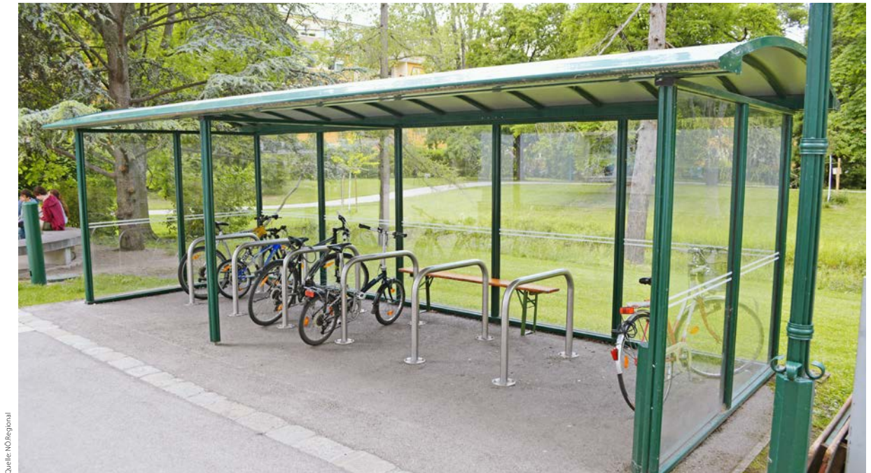
Abbildung 50: Beispiel für überdachten Radabstellplatz; Bad Vöslau
