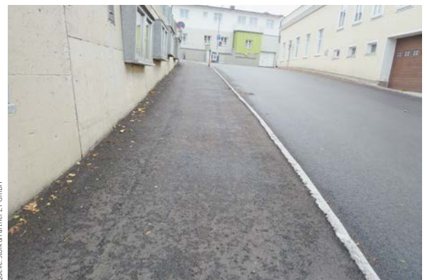
Abbildung 24: Beispiel für gut ausgeführten Gehsteig; Böheimkirchen, L5093
