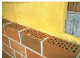
Sicherstellung der Winddichtheit durch korrekte Schichtenfolge
