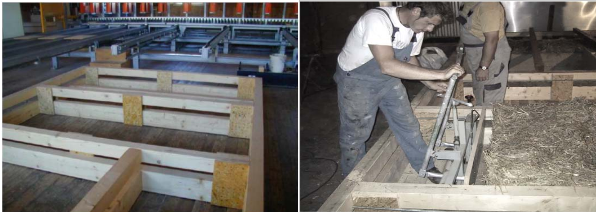
Abbildung 23: Außenwand Stroh-Holz-Leichtbaukonstruktion. Links: Vorfertigung der wärmebrückenreduzierten Wandelemente. Rechts: Befüllung der Wandelemente mit Strohballen (Meingast, 2005)
