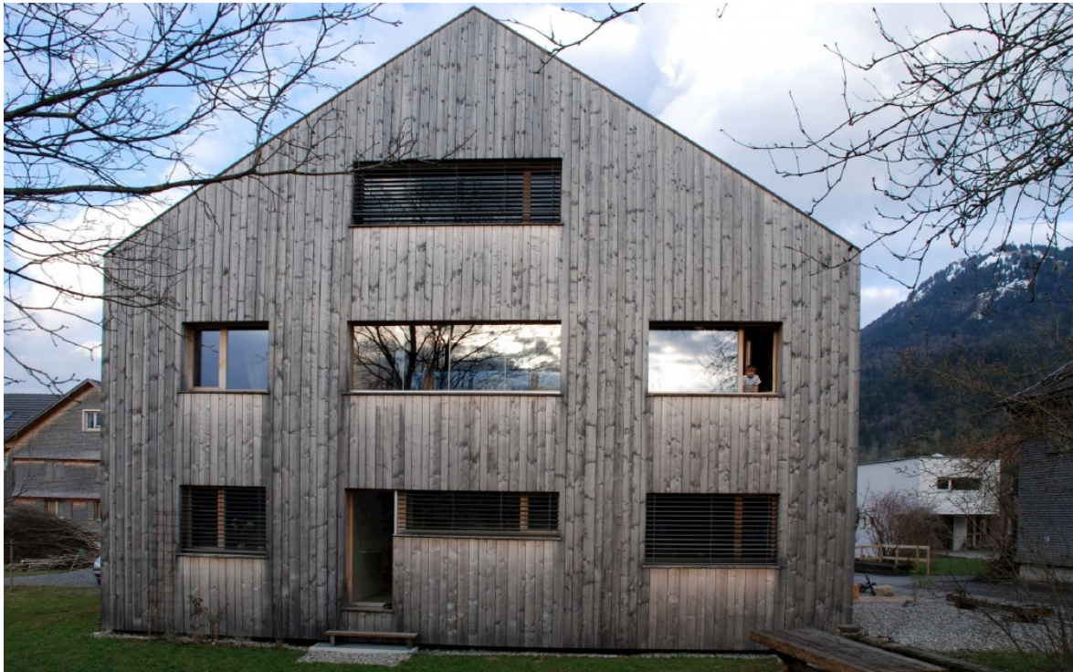
Abbildung 29: Südansicht des Zubaus (DI Ingomar Reumiller)
