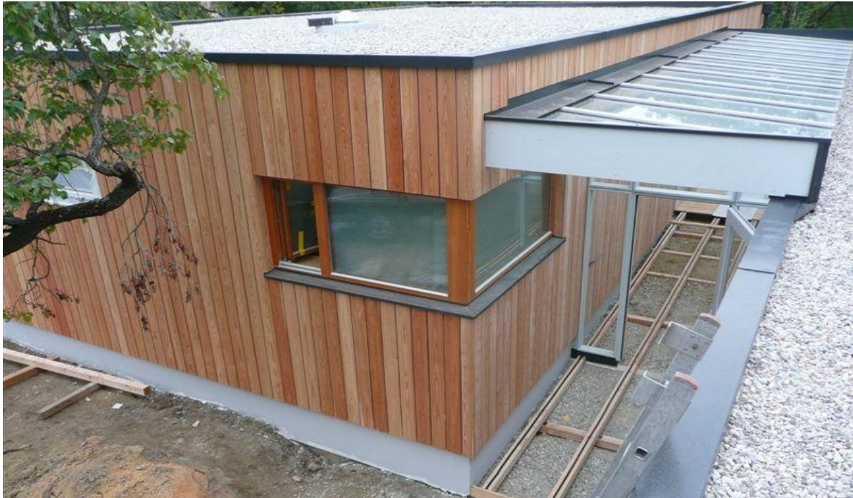
Abbildung 16: Wohnhaus Mautern mit fertiggestellter Fassade und Überdachung des Eingangsbereichs (www.systemhausbau.at / Kreativer Holzbau GmbH)
