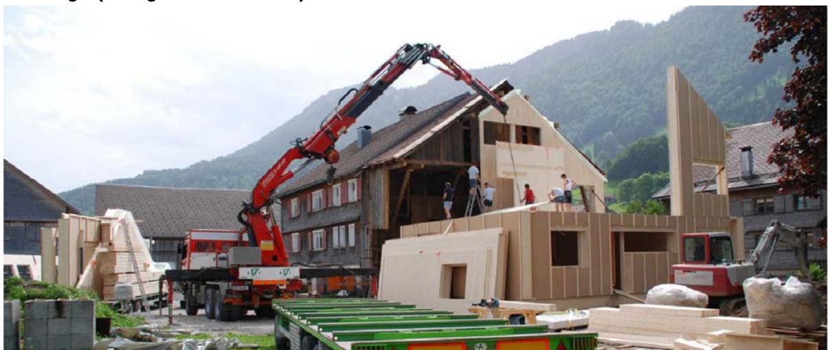
Abbildung 37: Montage vorgefertigter Holz-Stroh-Wandelemente (DI Ingomar Reumiller)
