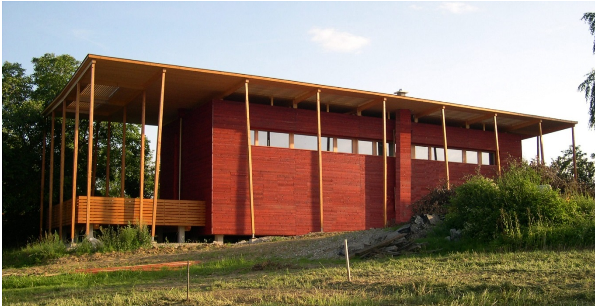
Abbildung 21: S-House nach Fertigstellung 2005 (Wimmer et al., 2006)
