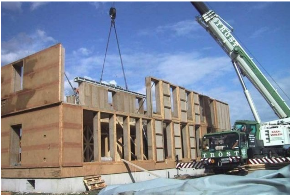
Abbildung 24: Montage der vorgefertigten Holz-Stroh-Elemente (Architekturbüro Reinberg ZT GmbH)
