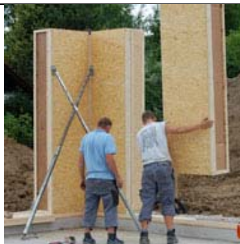
Abbildung 17: Anlieferung eines Deckenelements(ii), Montage von Wandelementen (re) (Kreativer Holzbau GmbH)
