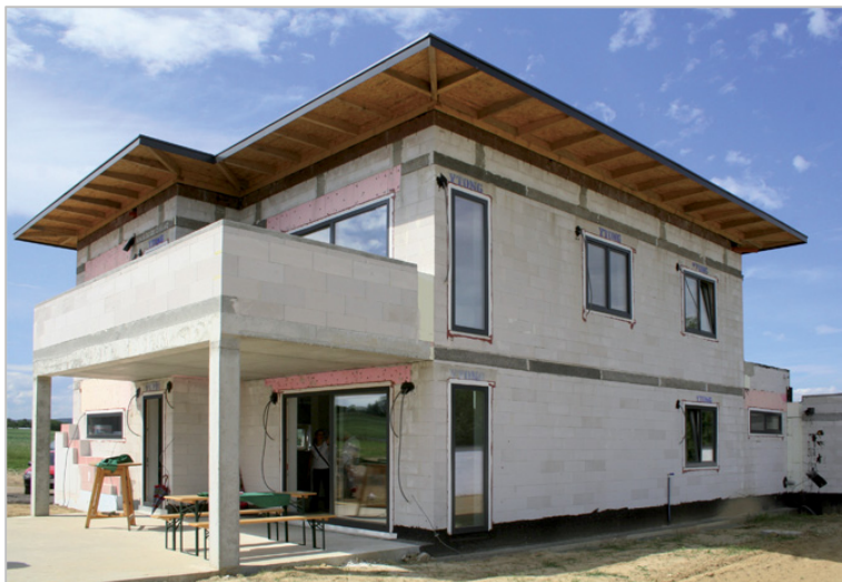
Abbildung 41: Einfamilienhaus im Passivhausstandard, Erbauungsphase (Xella, o.J.)
