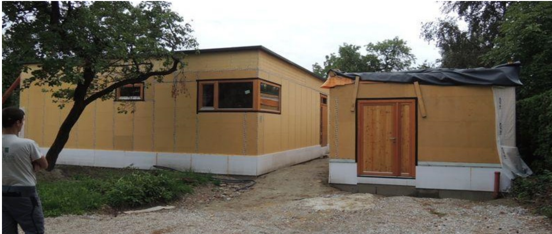
Abbildung 18: Abgeschlossene Montage der Außenhülle, Baukörper links mit luftdicht verklebten Fugen (Kreativer Holzbau GmbH)
