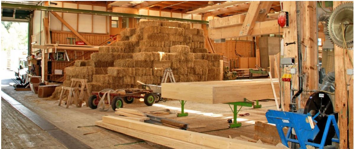
Abbildung 36: Die Außenwände wurden inklusive der Dämmung aus Strohballen vorgefertigt. (DI Ingomar Reumiller)
