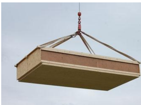
Abbildung 17: Anlieferung eines Deckenelements(ii), Montage von Wandelementen (re) (Kreativer Holzbau GmbH)
