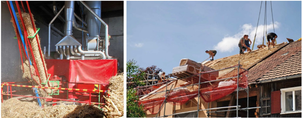
Abbildung 35: Links: Pressung der Strohballen. Rechts: Die Strohballen wurden folienverpackt auf die Baustelle geliefert und vor Ort eingebracht. (DI Ingomar Reumiller)
