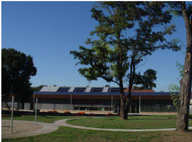
Abbildung 2: Kindergartenansicht von Süden [AEE INTEC]
