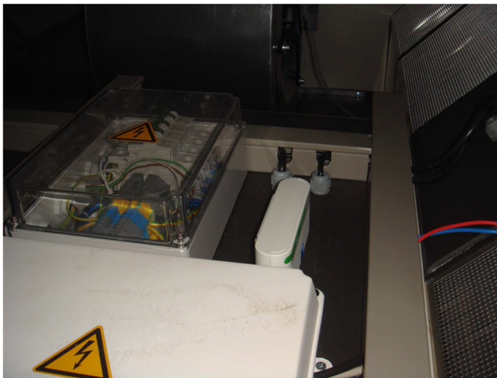
Abbildung 7: Messtechnikkomponenten Kindergarten Deutsch-Wagram (Bild links oben: Datenerfassung im Stromkasten, Bild links unten: Temperatur- und Feuchteerfassung in der Lüftungsanlage, Bild rechts: Strahlungssensor auf dem Dach montiert) [AEE INTEC]
